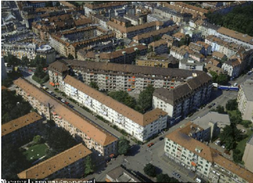
Sihlfeld-, Kanzlei-, Erismannstraße (Photo: ETH)
